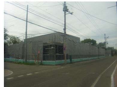
(建設中の柏地区生涯学習施設かしわのもり)
