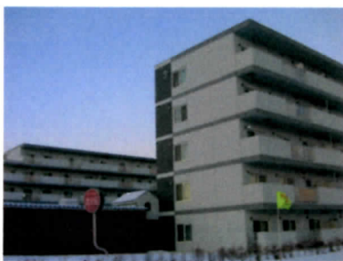
(市営住宅恵央団地)
