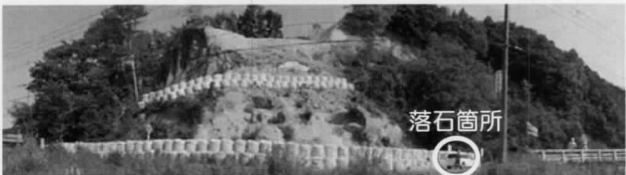
全景写真（応急対策後）
